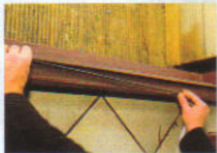
... damit die neuen, selbstklebenden Vorlegebänder in der Rahmeninnenseite gut halten.
