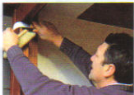
Die Glaser entfernen die alten Vorlegebänder, Silikonreste und andere Rückstände gründlich von der Rahmeninnenseite, ...
