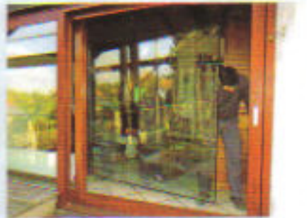
Mit Vakuumsaugern werden die neuen Scheiben sicher transportiert und eingesetzt.
