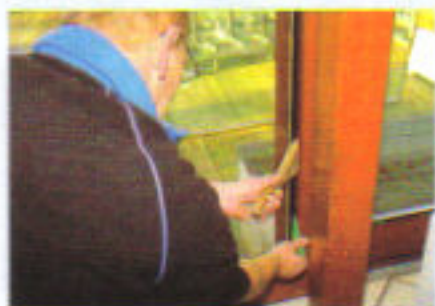
Die Verklötzung dient zum Ausjustieren der Scheibe, damit die Abstände an allen Seiten gleich sind.
