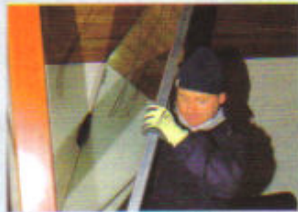
Nun kann die alte Scheibe entfernt werden.
