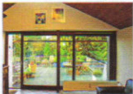
Die Terrassentür stammt aus dem Jahr 1982, die beiden Holzrahmen sind in gutem Zustand.
